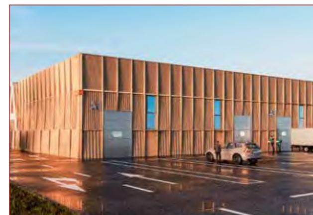
Меблева фабрика та магазин Віяр, Одеса, вентиляційні установки AHE-300WB1 (4 шт.)
