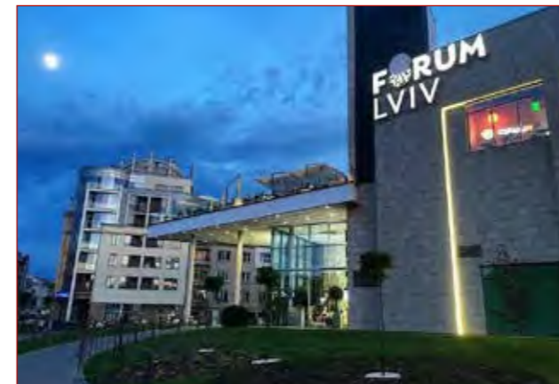
ТРЦ Форум-Львів, деякі торгові бутікі, центральна система із застосуванням 43 шт касетних та каналних фанкойлів Idea
